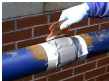
Belzona layer of Belzona 1212 applied
